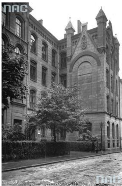
Rys.1. Budynek komunalny użytkowany przez szkolnictwo powszechne przy ul.: Loretańskiej 18 – siedziba m.in. rektoratu i dziekanatu (jeden dla obu wydziałów), przekazany przez Gminę m. Krakowa w zarządzanie Akademii Górniczej w l. 1919-30 (in. Grodzkiej 15). Foto: NAC: 1-N-3118-1
