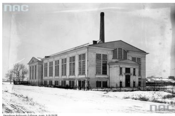
Rys.10. Budynek Laboratorium Elektromaszynowego Akademii Górniczej, ul. Reymonta 7, wzniesiony w l. 1927-28 według projektu arch. I. Stelli-Sawickiego, będący darem Górnośląskiego Związku Przemysłowców Górniczo-Hutniczych w Katowicach – 1932-02. Foto: NAC nr 1-N-3128
