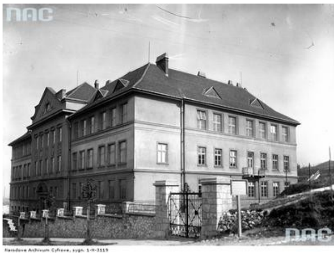
Rys.3. Budynek IV Gimnazjum w Podgórzu, ul. Krzemionki 11, wzniesiony w l. 1913-18 według projektu arch. Jerzego Struszkiewicza, będący tymczasową siedzibą Akademii Górniczej w latach 1920-72 – 1927-10. Foto: NAC: 1-N-3119
